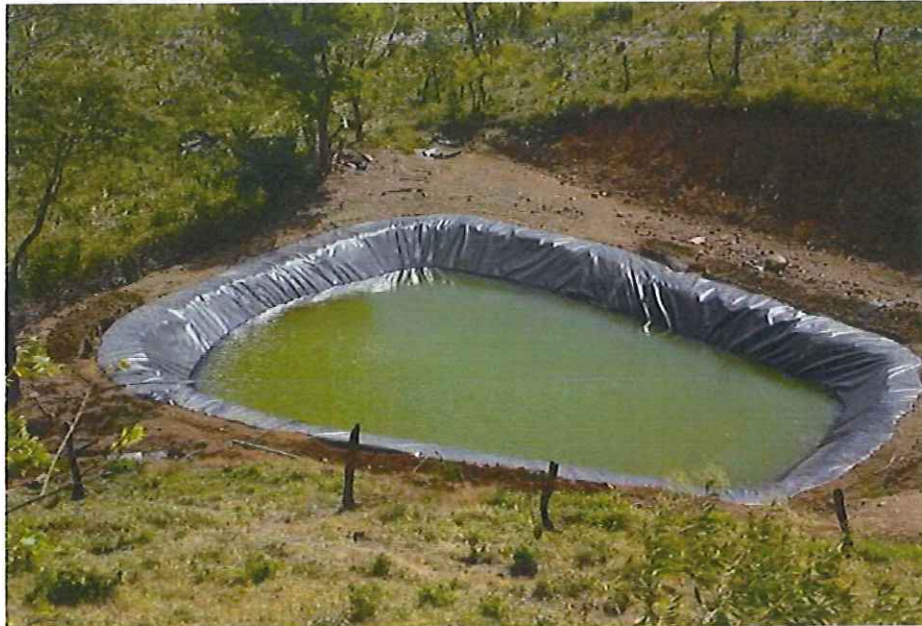
Fotografía 9: Reservorio revestido con geomembrana
