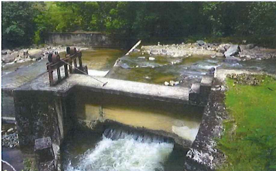
Fotografía 3: Azud construido en el río San Francisco, el cual presenta una rejilla lateral para el ingreso del recurso hídrico construido por la Junta General de Usuarios del Sistema de Riego Santa Isabel.
