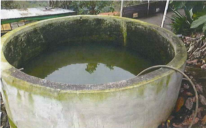
Fotografía 11: Tanque de hormigón
