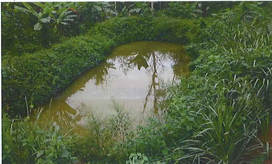
Fotografía 10: Reservorio sin revestimiento
