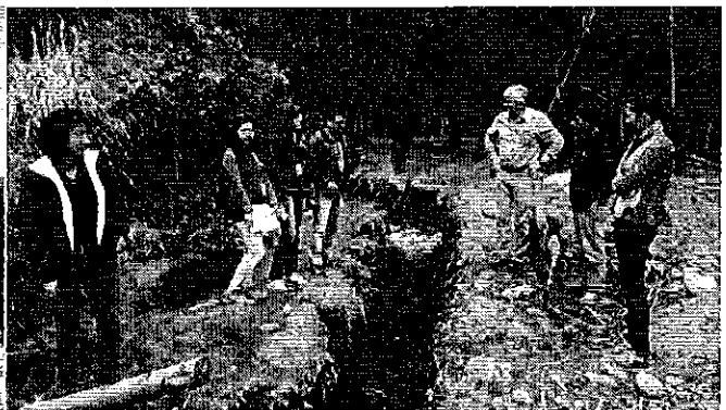
Foto 2.- Inspección a la captación y conducción.
