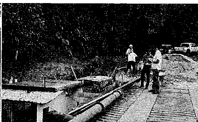
Foto 10.- Captación 2 y estación de bombeo
