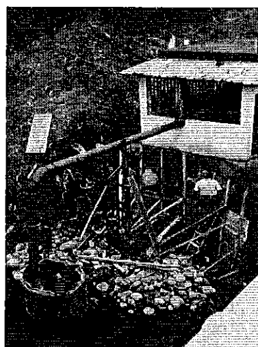
Foto 12.- Adecantamiento en captación.
