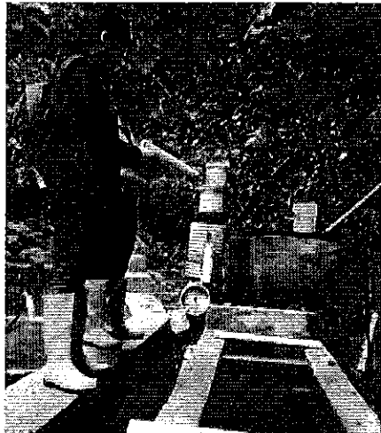
Imágen 7. Inspección de la fuente y obras de captación del cantón Paquisha, por el equipo ARCA.
