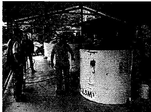
Ilustración 2. Planta de Tratamiento de Aguas Residuales de la EPMAPARS-P.
