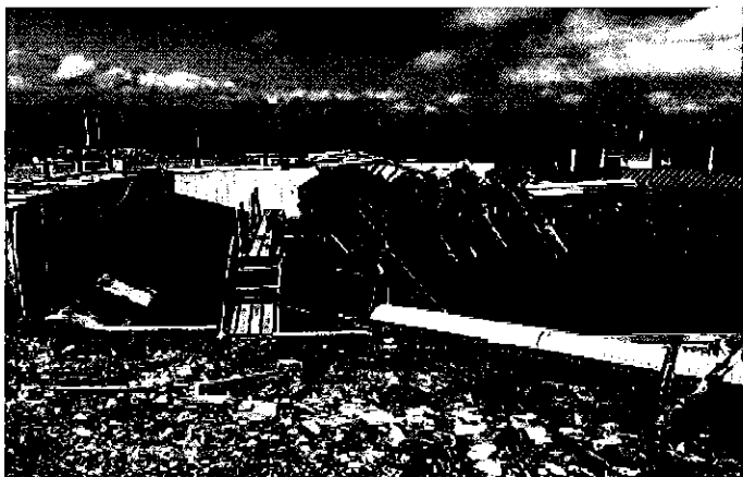
Foto 3.- Sistema de captación por bombeo Langostino S.A
