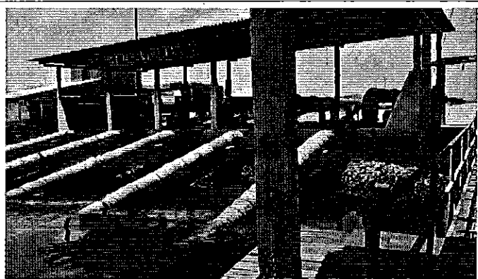
Foto 7.- Bombas en el estero de Granjas Marinas
