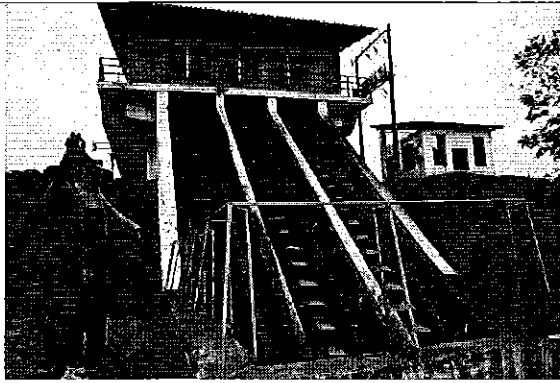
Ilustración 3. Inspección de la Planta de Tratamiento de Aguas Residuales en Babahoyo.
