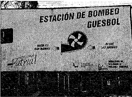
Ilustración 7. Recorrido de Control en la estación de bombeo Guesbol.
