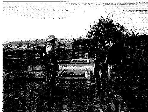
Fotografía 4. Equipo ARCA y EMAARS en visita técnica al Tanque de reserva de La Atravesada.
