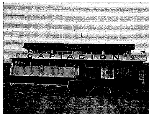
Fotografía 6. Estación de bombeo 1 en la captación del Río esmeraldas, EAPA San Mateo.
