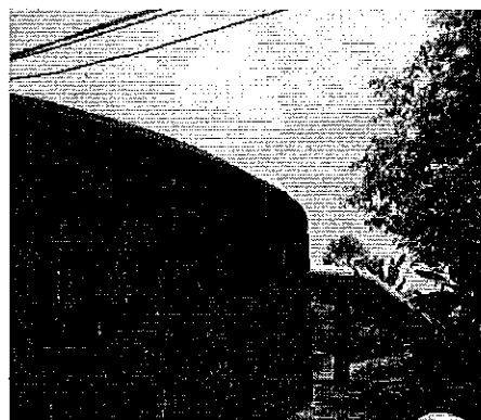
Fotografía 8. Tanque de carga, EAPA San Mateo.
