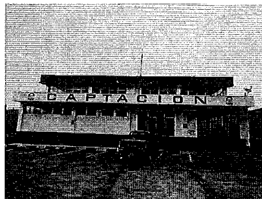
Fotografía 6. Estación de bombeo 1 en la captación del Río esmeraldas, EAPA San Mateo.
