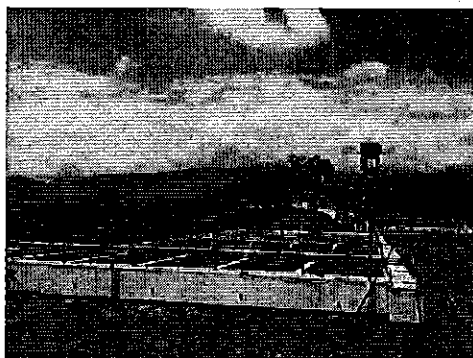
Fotografía 3. Planta de tratamiento Casacay
