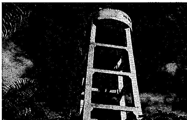
Ilustración 1. Inspección de Tanques Elevados
