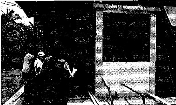
Ilustración 4. Inspección de Pozos y Sistema de Bombeo
