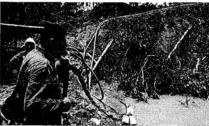
Foto 7 Captación de agua TERRAMININ S.A.
