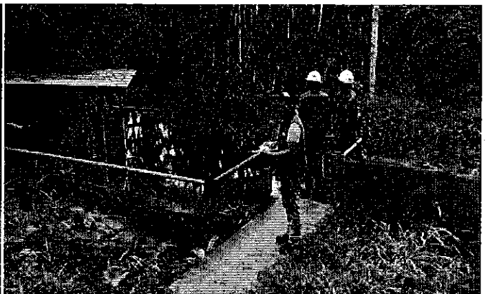
Foto 4.- Captación de agua 3.
