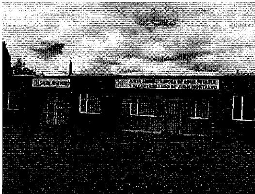
Oficinas de la Junta de Agua Potable y Alcantarillado Juan Montalvo
