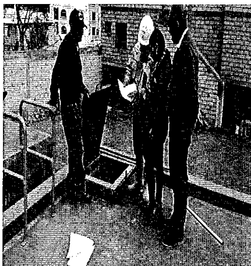
Ilustración 2. Inspección tanque de abastecimiento, de la JAAP San Buenaventura del Cantón Latacunga.
