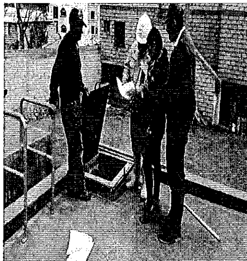
Ilustración 2. Inspección tanque de abastecimiento, de la JAAP San Buenaventura del Cantón Latacunga
