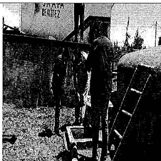
Ilustración 4. Inspección tanques de reserva y desinfección mediante clorogás, de la Junta Administradora de Agua Potable y alcantarillado Benítez Cantón Peñileo.
