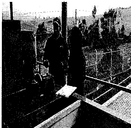
Ilustración 2. Inspección tanque de abastecimiento, de la Junta Administradora de Agua Potable y alcantarillado Regional Yanahurco Cantón Mocha.
