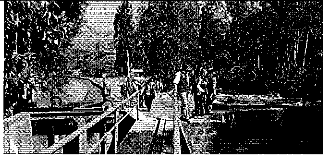
Fotografía 2. Recorrido por la Infraestructura de captación del sistema El Pisque.
