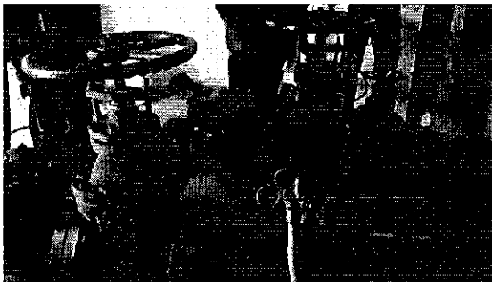
Ilustración 5 Sistema de control de válvulas - Ambato
