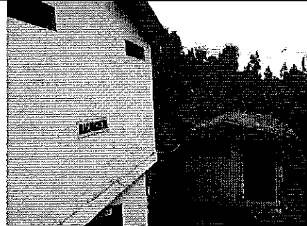
Ilustración 4 Estación de Bombeo Machachena - Ambato
