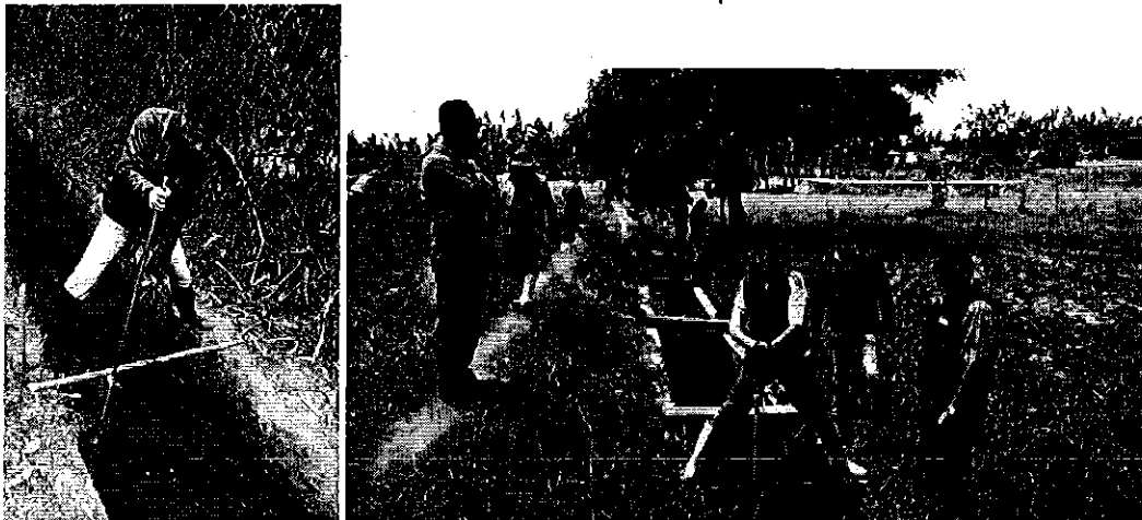
Fotografía 5. Aforo de caudales en la Captación, Conducción y antes del 1er Ramal
