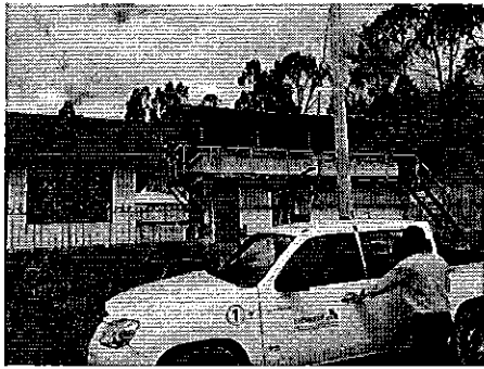
Ilustración 5 Planta de Tratamiento Aireadores
