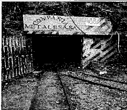
Fotografía 1. Inspección técnica Área Minera Unión y Progreso
