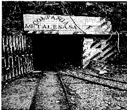
Fotografía 1. Inspección técnica Área Minera Unión y Progreso
