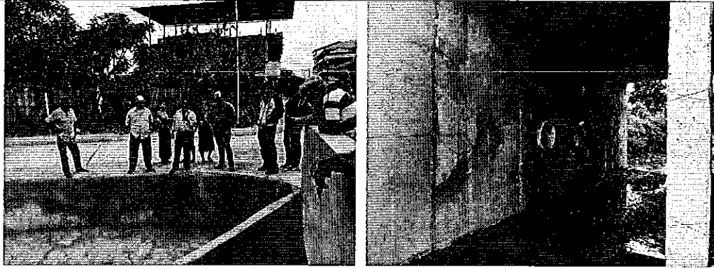
Fotografía 1. Inspección técnica en el cauce del río Nuevo
