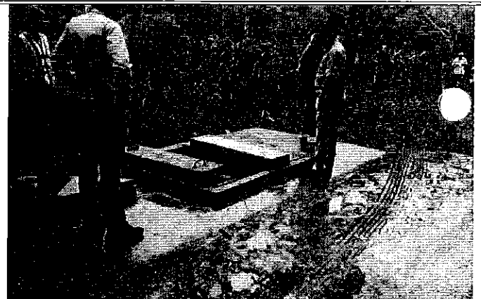
Ilustración 4. Cámaras de hormigón para la instalación del sensor electro-magnético.
