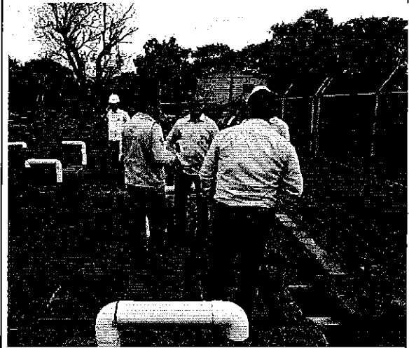
Fotografía 6. Planta de tratamiento Aguas Residuales El Laurel
