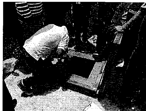
Fotografía 2. Control a la implementación del Plan de Mejora de los servicios de la JAAP de Guanujo.
