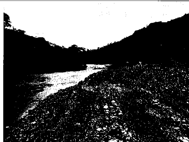
Fotografía 4. Río Nangaritzá, inspección técnica ante posibles afectaciones
