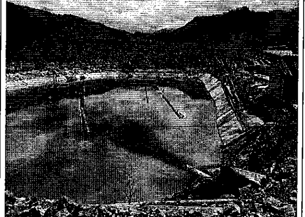
Fotografía 8. Área de relaves, Inspección Planta de Beneficio "Paraíso 1"
