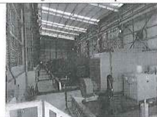
Fotografía 7. sistema de bombeo,
