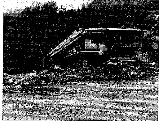
Foto 2. Viviendas Afectadas km 5.5 de la vía Cuenca-Molleturo- El Empalme.
