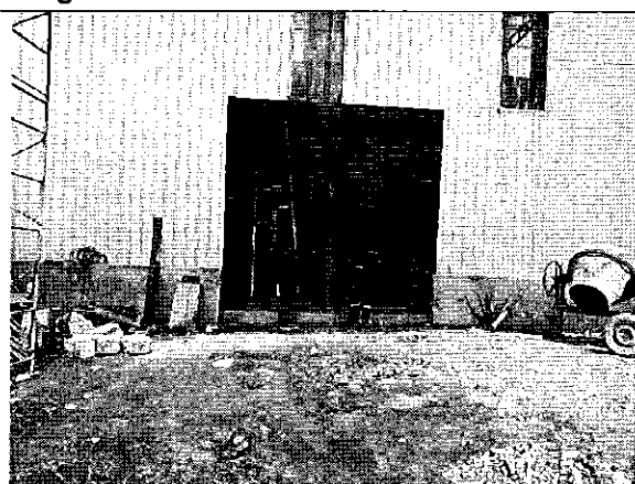
Inspección Construcción cercana al río Mangalpa
