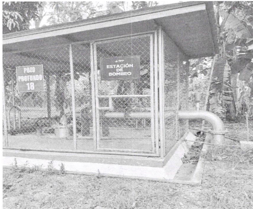
Control a las obras de captación de agua cruda
