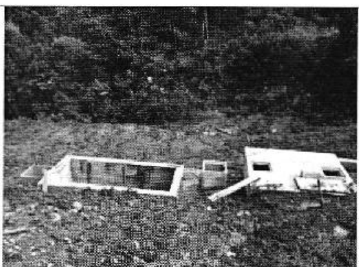
Planta de tratamiento en construcción con avance del 70%
