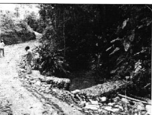
Embaulamiento del río Pizará (aguas arriba)
