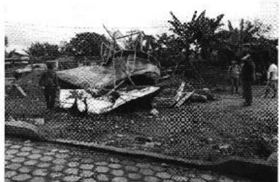
Figura 2: Tanque elevado colapsado por terremoto en el Barrio 4 de diciembre - El Carmen
