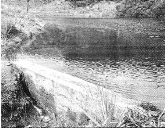
Fotografía N°1.- Muro construido con las especificaciones del MAE que permite elevar el espejo de agua de la laguna de Totoracocha
