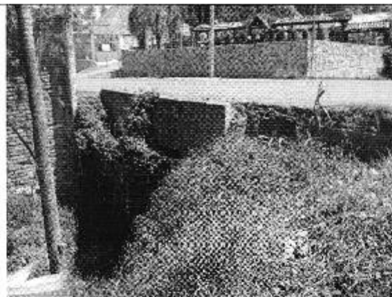
Fotografía N°16.- Puente sobre el dominio hídrico público
