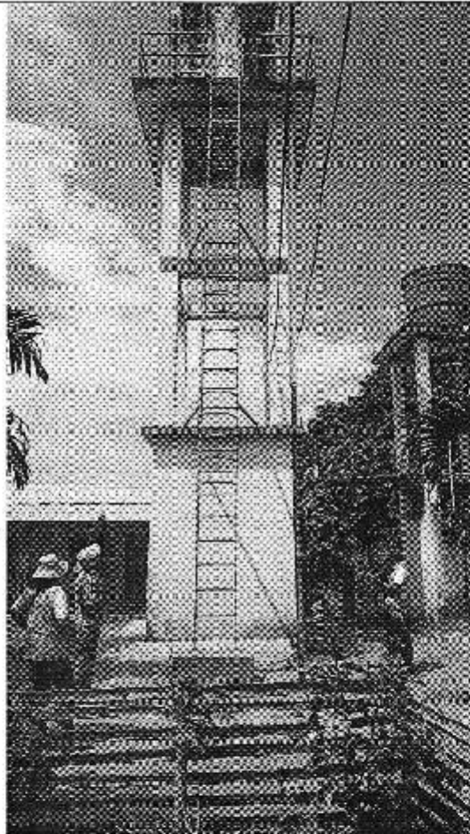
Ilustración 4. Inspección técnica del pozo profundo y tanque elevado del sistema de agua potable de la Organización Carolina de Puerto Real.
