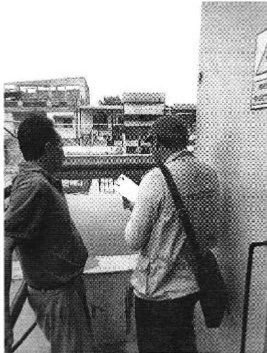
Ilustración 2. Inspección técnica en la planta de tratamiento de la JAAP La Unión.
