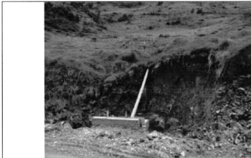
Fotografía 1. Tubería de drenaje-Caso Celec
