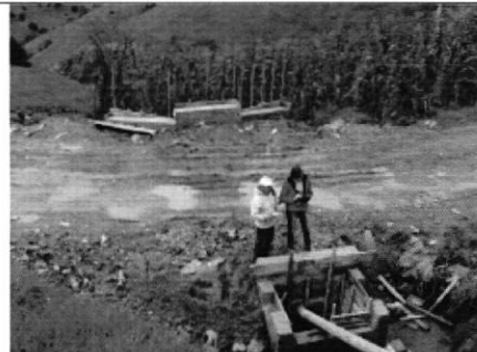
Fotografía 2. Muro de contención para evitar deslizamiento de la vía de tercer orden-Caso Celec
