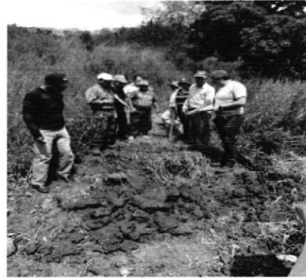
Fotografía 6. Excavación para constatar captación de agua potable en el domicilio del Arq. Edgar Rodas.
