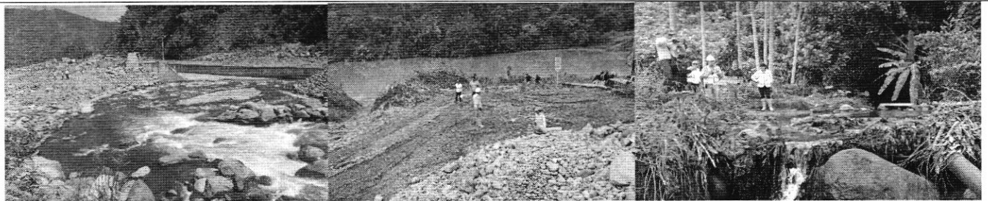
Fotos 1, 2 Y 3.- Inspección casos Hidrotambo, Cía. Minera COMIANGE S.A, - ACQUAD'OR C.A.
