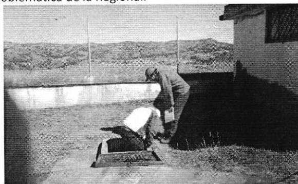
Ilustración 3. Revisión del Sistema de agua potable y alcantarillado de la JAAP Regional Vinchoa.
