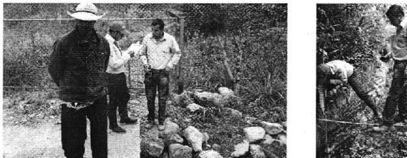
Fotografía 4. Visita al sitio de captación y conducción
