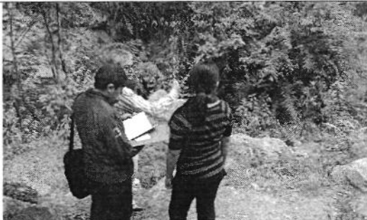
Fotografía 3. Inspección Quebrada Sector El Plateado
