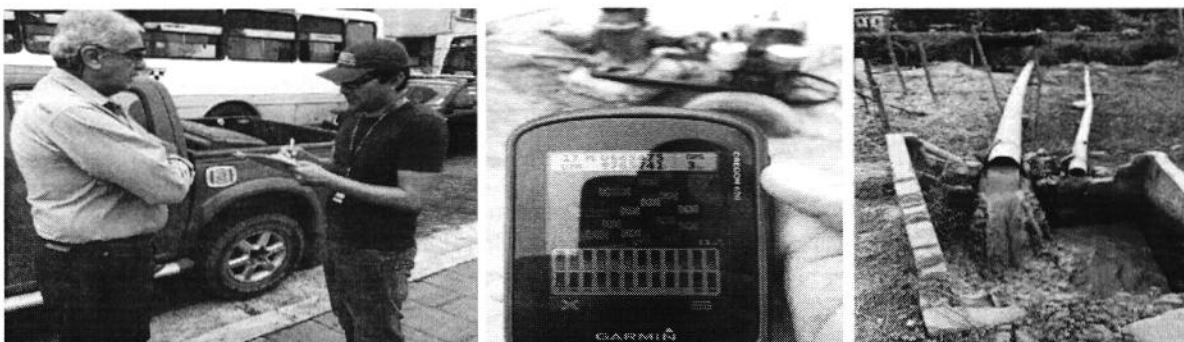
Fotografía 3. Izq. Reunión de trabajo, Centro. Georeferenciación punto IPRH, y Der. Ubicación de Sistema de bombeo.
