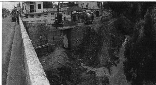
Inspección en Ingenio Azucarero Valdez
