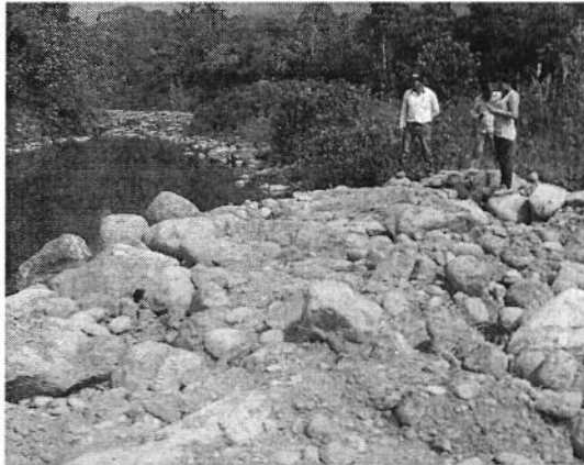
Inspección Obstrucción Río Balao
