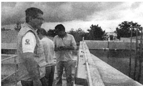
Ilustración 1. Inspección a la planta potabilizadora de Atahualpa.
