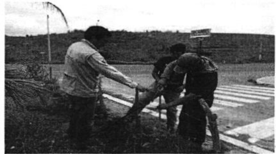
Ilustración 6. Verificación y control de presiones en redes de distribución.
