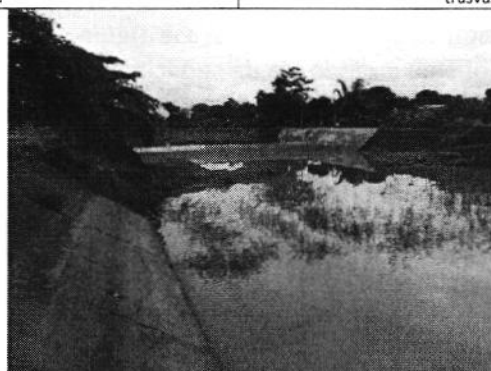
Fotografía 3. Construcción de la represa sobre el río Chilintomo
